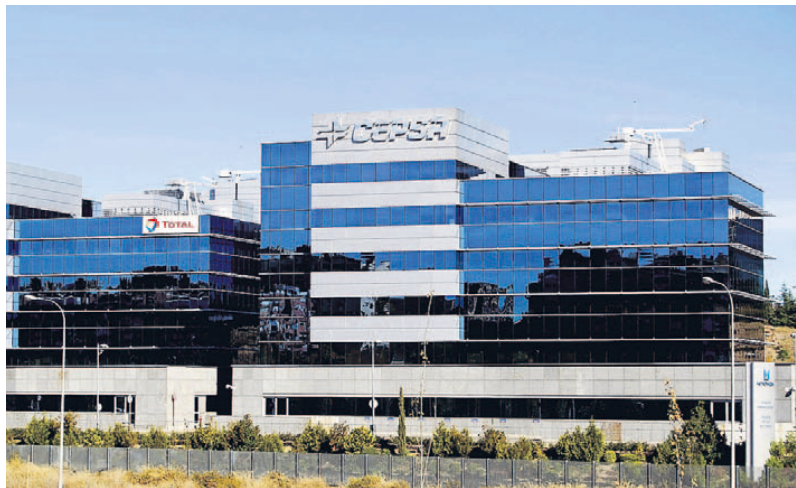
Sede central de la petrolera Cepsa en el Parque Empresarial Juan Carlos I de Madrid. | EFE
